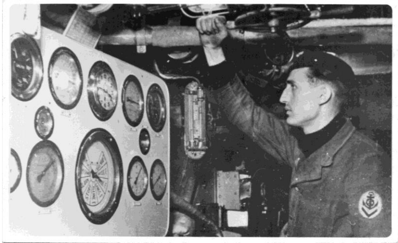
Seewach- und Gefechtsstation Kesselraum Brummer
